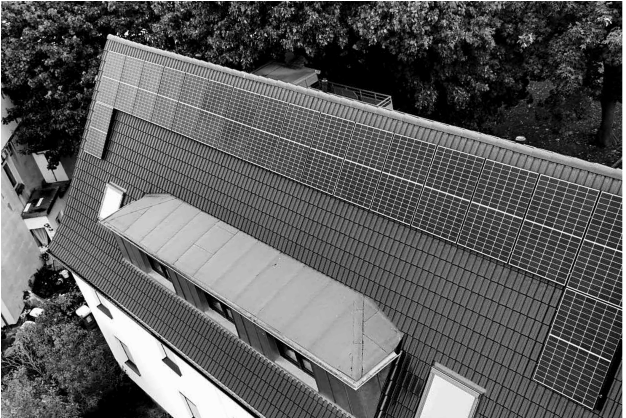
Die erste Photovoltaikanlage der Handwerksbau AG produziert seit dem 30.07.2025 Strom.
