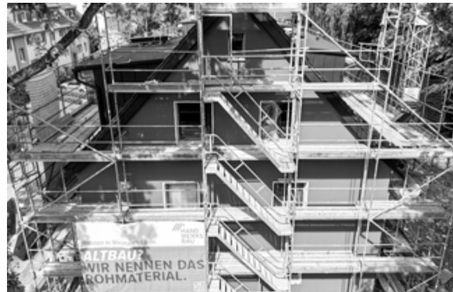
Nachdem die Fassade gedämmt wurde, werden im letzten Bauabschnitt Balkone angebaut .
