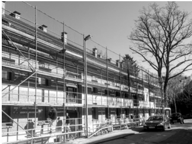
Nachdem die Fassade gedämmt wurde, werden im letzten Bauabschnitt Balkone angebaut .
